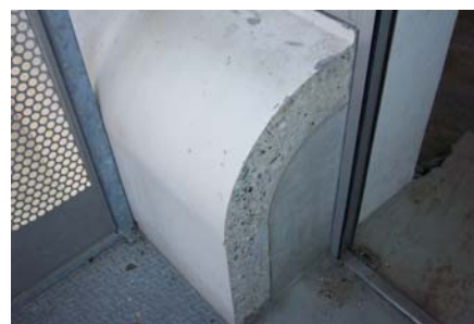
Détail d'un bandeau de façade en béton
